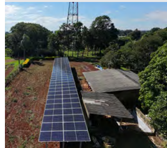
Solarenergie von der neuen Photovoltaikanlage
